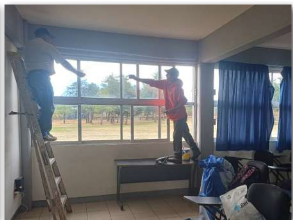
Instalación de cortineros para las aulas
